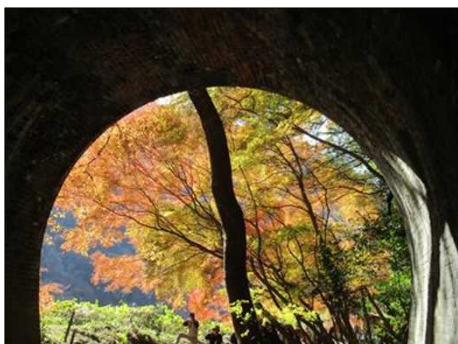
6174 トンネル内は薄明り
