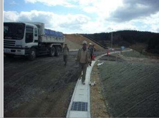
219 道路造成工事地帯を行く
