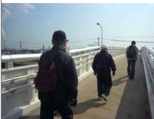
102 名四国道(23号線)にかかる歩道橋
