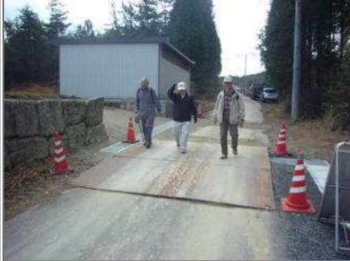
217 道路造成工事中地帯に入る
