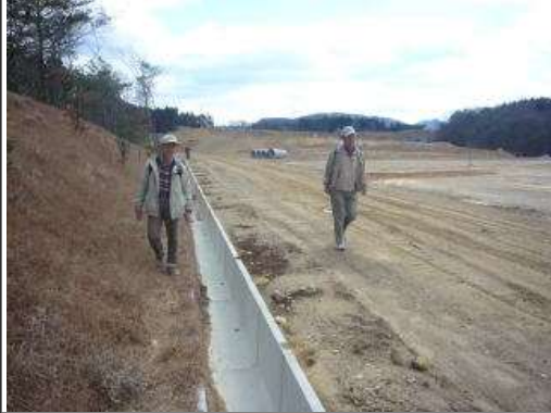
218 道路造成工事地帯を行く
