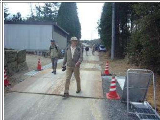
215 道路造成工事中地帯に入る
