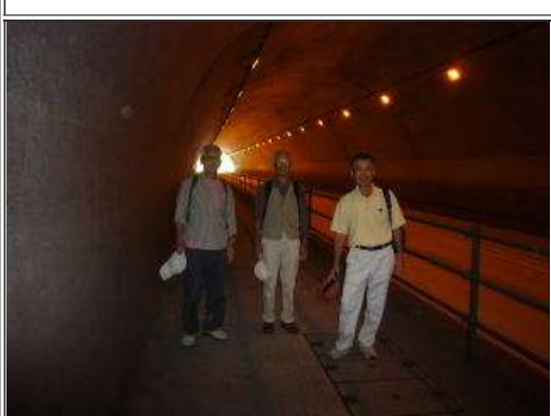
34 河岐トンネル
