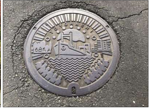
23 マンホールの蓋
