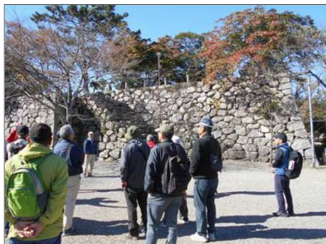
1301 建物は倒壊し石垣のみ
