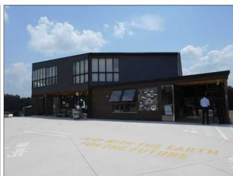
1041 洒落た建物の中に案内所
