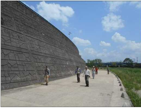
1049 高いコンクリートの壁(堤防)
